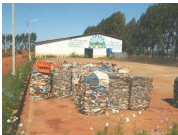
Usina de reciclagem de lixo (2006)
