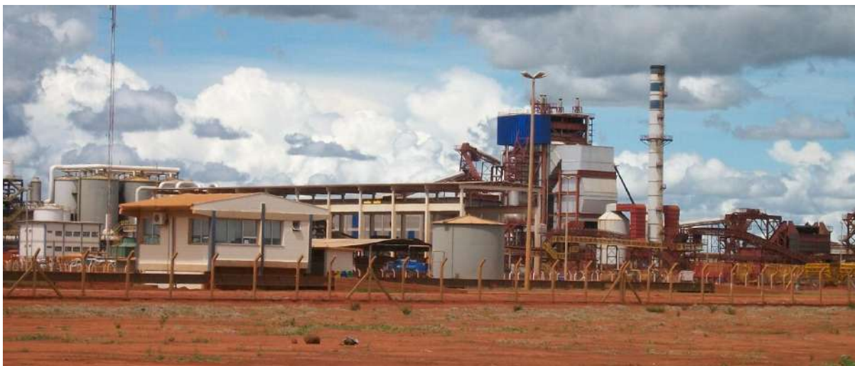
14/02/2011 – Unidade Porto das Águas
