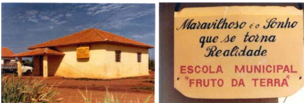
Primeira escola e placa colocada nela (1982)
